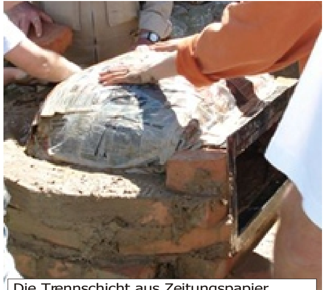
Die Trennschicht aus Zeitungspapier verhindert eine Verbindung mit dem Lehm
