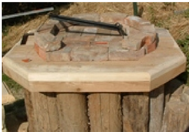
Das Fundament aus Stämmen, der Tisch aus Tanne, darauf die Basis aus gebrauchten Mauerziegeln
