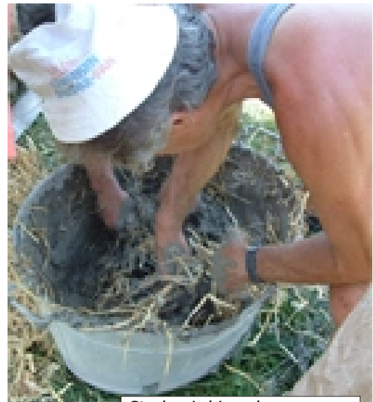
Stroh wird in sehr feuchten Lehm gut benetzt
