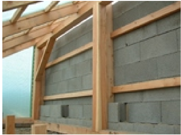
Innenansicht der Holzkonstruktion
