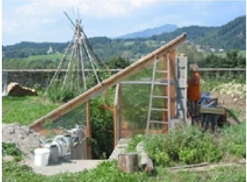
Die Dachneigung beträgt in St. Georgen 30°
